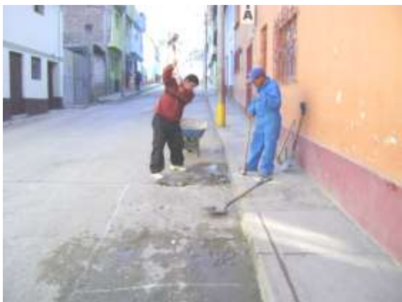
Trabajadores de EPS reparando filtraciones existentes
