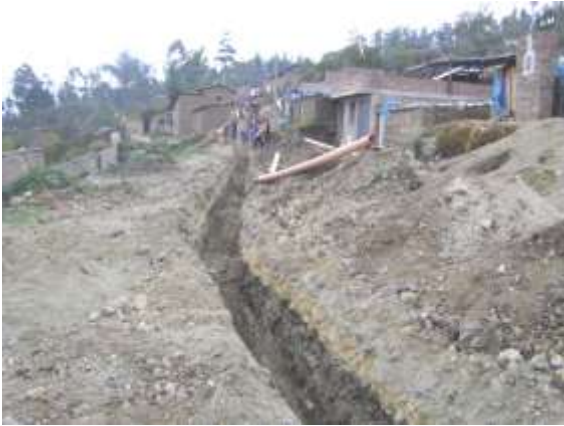
Instalación de redes alcantarillado zonas altas de la ciudad
