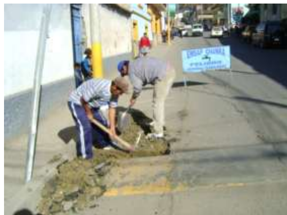
Trabajos de EPS para identificar conexiones clandestinas
