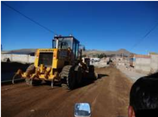
Trabajos que motivaron cambio de local del evento
