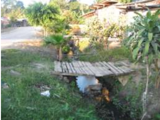
Acequia de desagües en zonas periféricas
