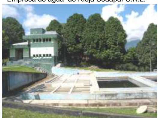
Planta de tratamiento de agua potable Rioja
