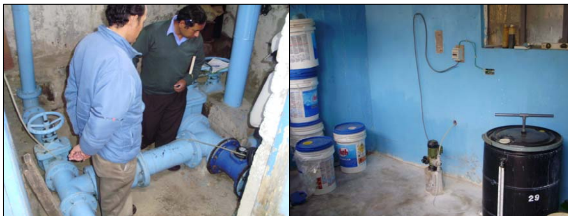
Foto 2.4.5: Reservorio Wassipara – Caseta de válvulas – sistema de desinfección
