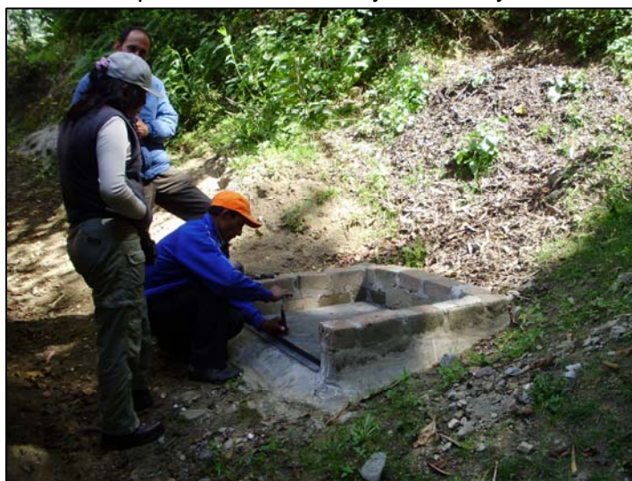
Foto 2.4.2 Captación Mantial Tonlyncco Huayco
