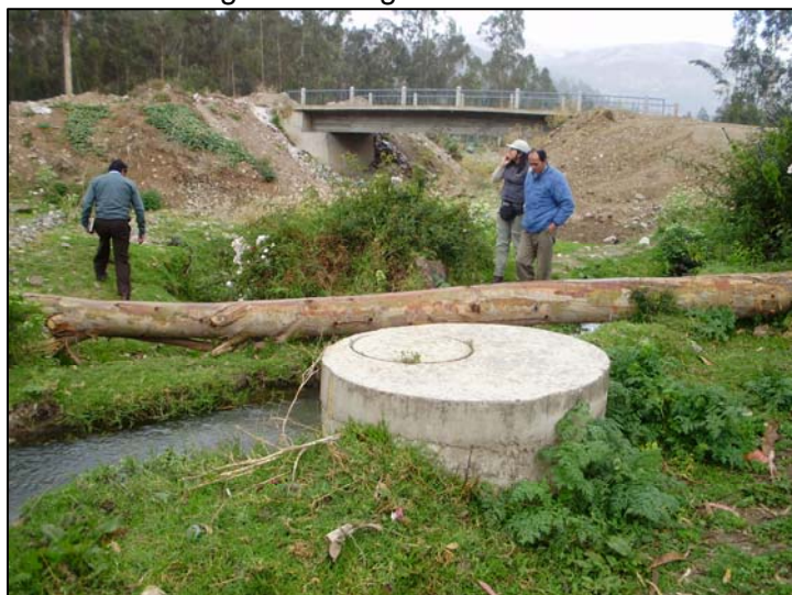
Foto 2.4.9: Descarga de deságüe a río Chumbao - Andahuaylas
