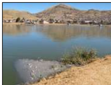
4-2. Laguna primaria de PTAR El Espinar
