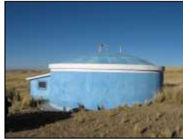
3-2. Reservorio Habitad Ciudad Humanitaria (250 m 3 )
