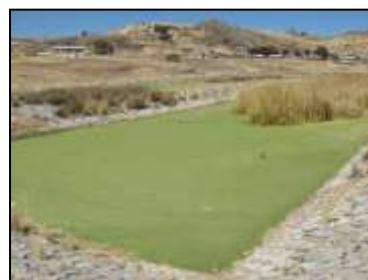
6-3. PTAR San Cristóbal de Balsave
