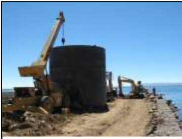
1-1. Captación Chimú en proceso de construcción
