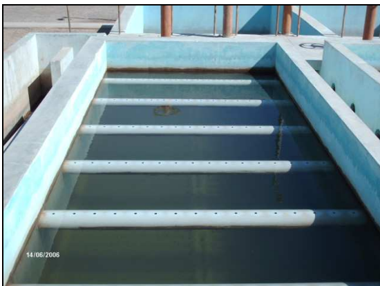
Gráfico N° 1.3 Decantador laminar
