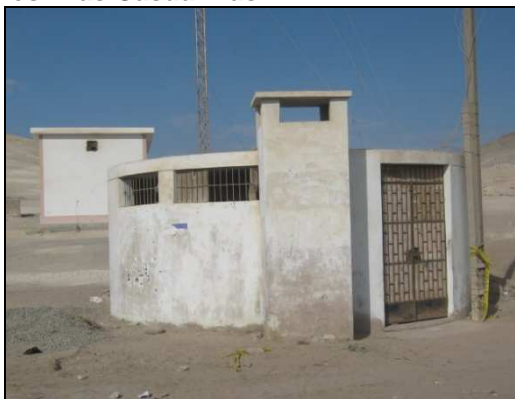
Estación de Bombeo de Aguas Residuales “Las Casuarinas”
