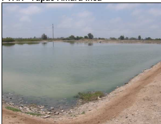
Foto N°14 PTAR “Túpac Amaru Inca”
