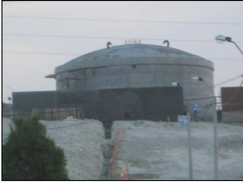
Foto N°6 Reservorio RA-4 (V=1.500 m3)
