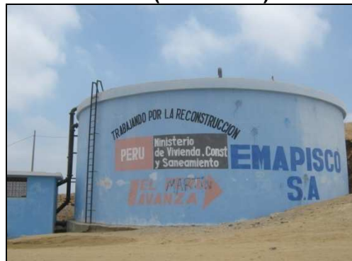
Foto N°5 Reservorio RA-3(V=1.000 m3)
