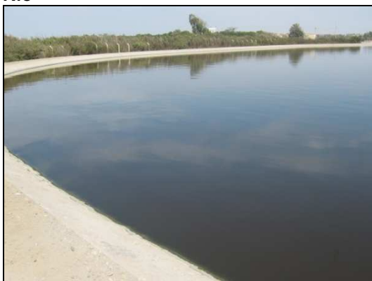
Foto N°13 PTAR “Boca del Río”
