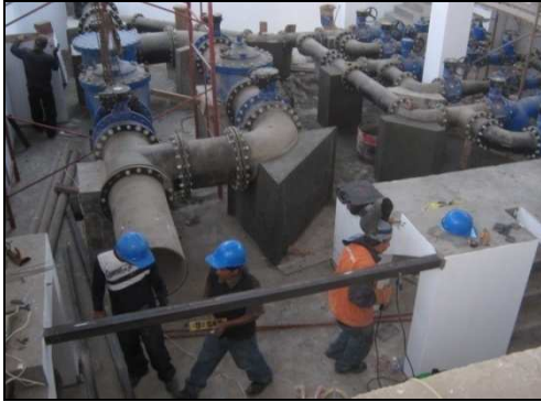
Foto N°3 Nueva Cámara Repartidora de Caudales en proceso de ejecución
