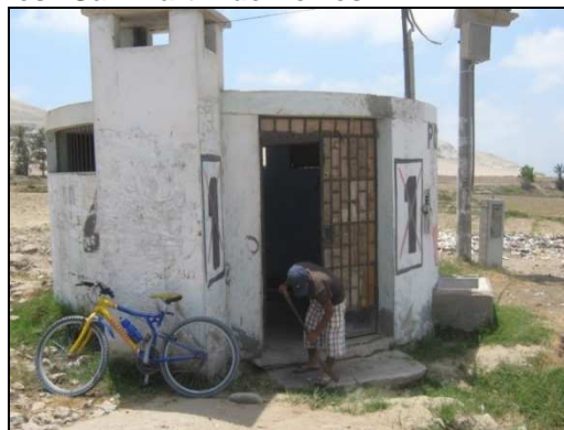
Estación de Bombeo de Aguas Residuales “San Martín de Porres”
