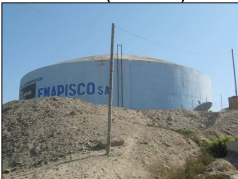
Foto N°4 Reservorio RA-2 (V=4.200 m3)
